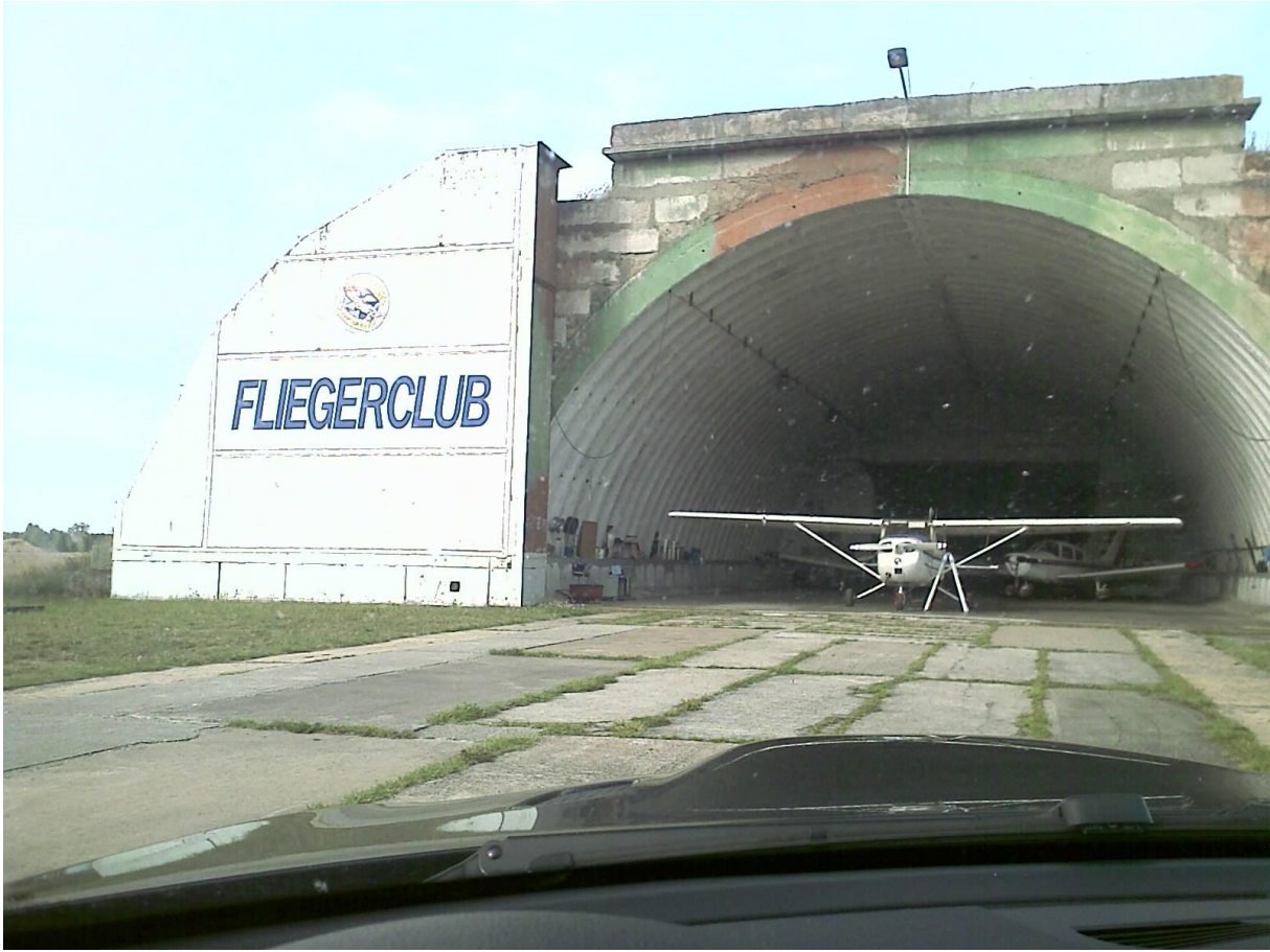
Da ist Bjoern's Hangar 😊
